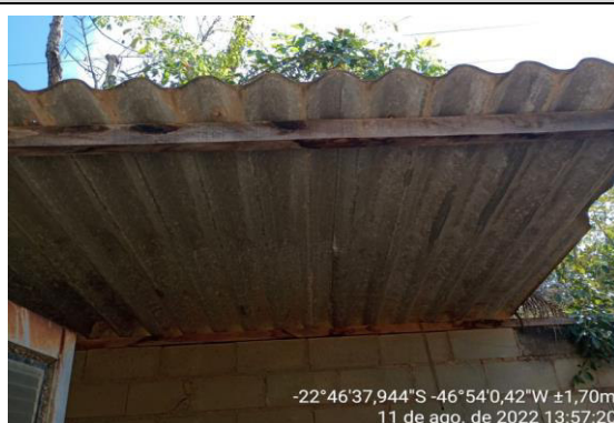
Foto 2 - Telhado da estrutura
