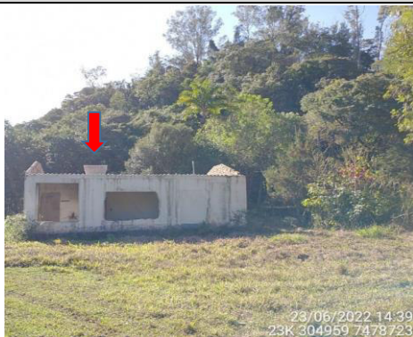
Foto 1 - Vista geral da estrutura, caixa d'água indicado pela seta
