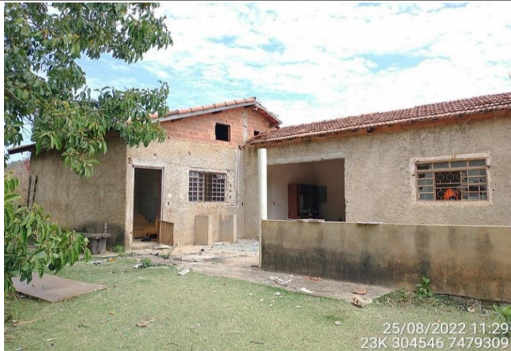
Foto 1 - Estrutura da casa 24
