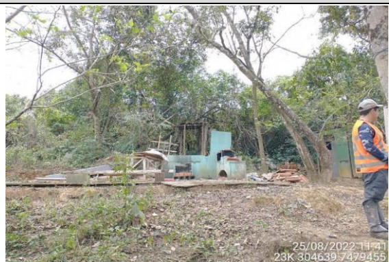
Foto 1 - Estrutura da casa 20
