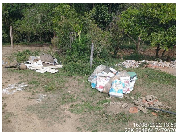
Foto 5 - Limpeza e segregação dos resíduos (Laudo 15 - Casa 14). (Data: 16/08/2022).
