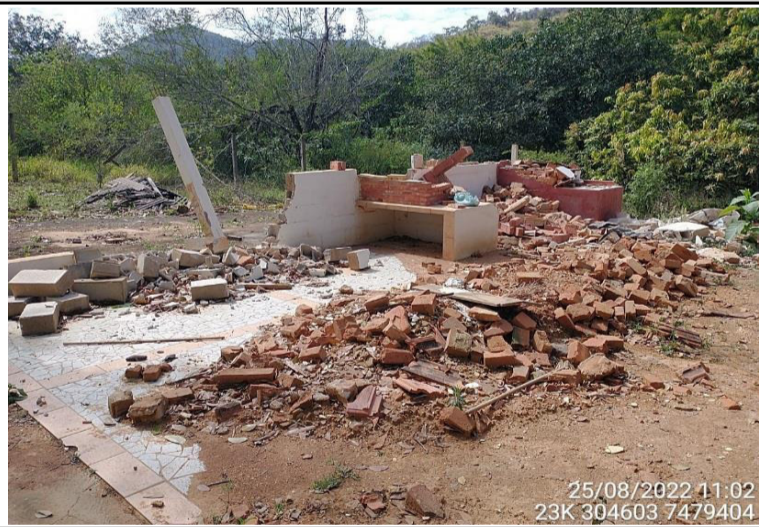
Foto 2 - Casa 22b parcialmente demolida
