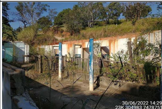
Foto 1 - Visão externa da estrutura
