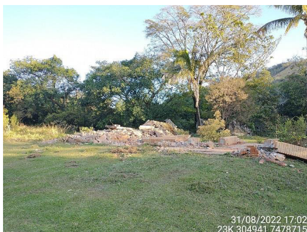
Foto 15 – Demolição da casa 43 no laudo 26. (Data: 31/08/2022).
