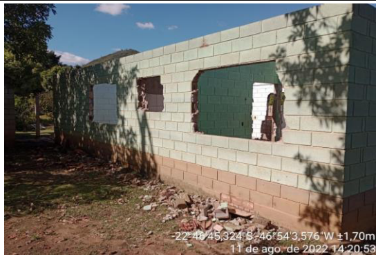
Foto 1 - Estrutura da Casa 15.
