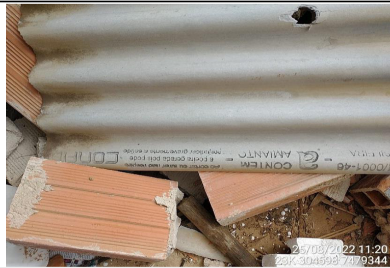
Foto 2 - Telhas de amianto
