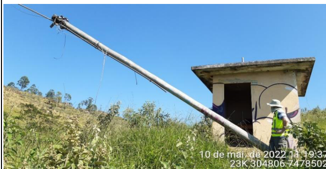
Foto 2 - Vista geral da estrutura
