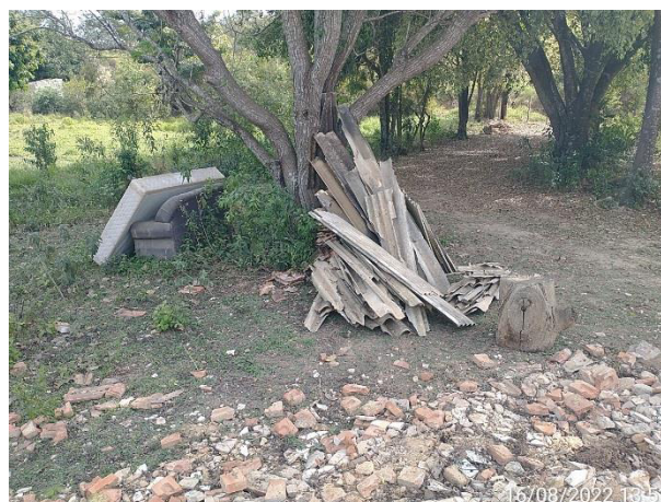
Foto 6 - Limpeza e segregação dos resíduos (Laudo 14 – Casa 15). (Data: 16/08/2022).
