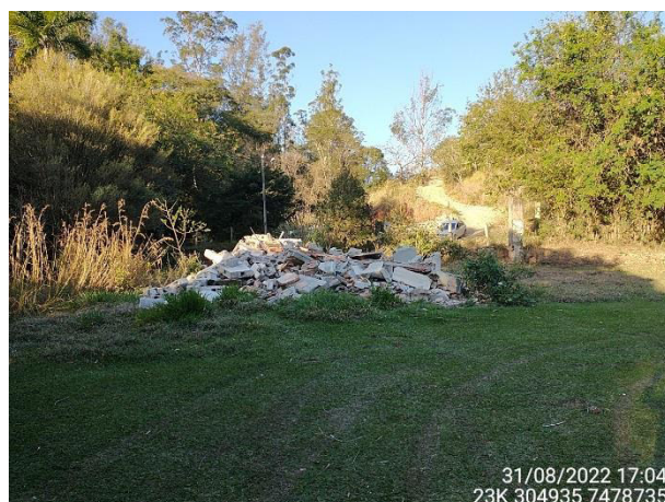
Foto 16 – Demolição da casa 42 no laudo 26. (Data: 31/08/2022).
