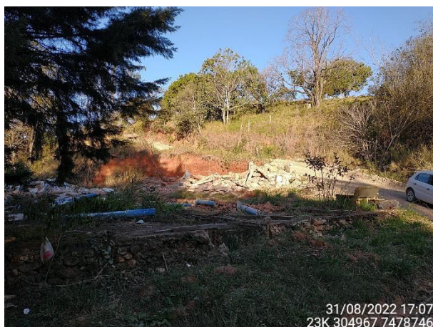
Foto 13 – Demolição da casa 41 no laudo 26. (Data: 31/08/2022).
