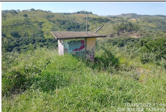
Foto 1 - Vista geral da estrutura
