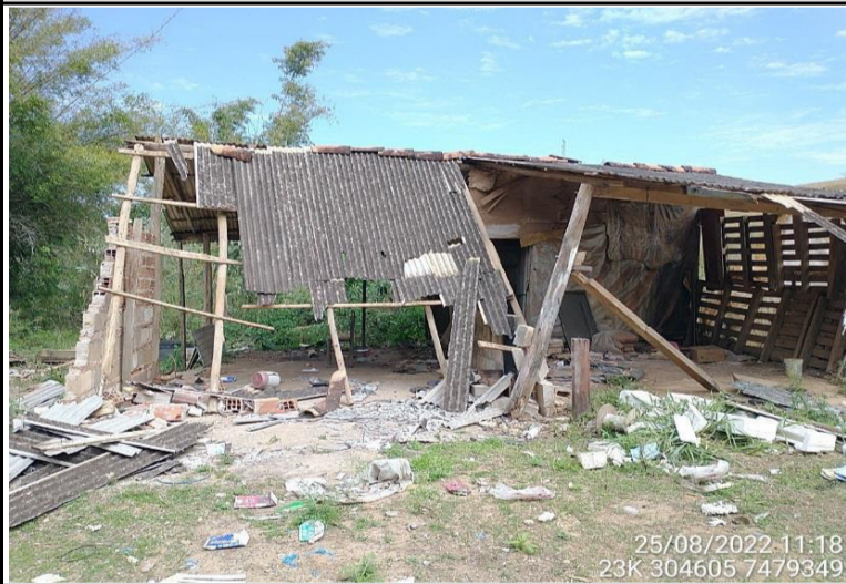
Foto 1 - Estrutura da casa 23
