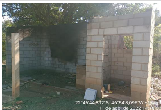
Foto 3 - Estrutura do fundo da casa 15.
