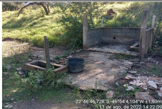
Foto 1 - Estrutura da Casa 16.
