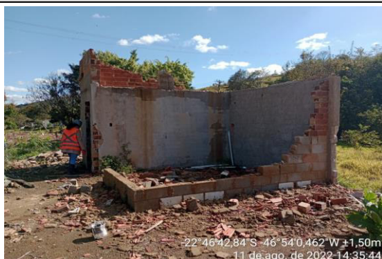
Foto 1 - Estrutura parcialmente demolida
