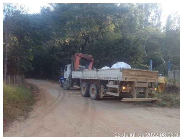
Foto 2 - Limpeza e segregação dos resíduos (Laudo 26 - Casa 41). (Data: 23/07/2022).
