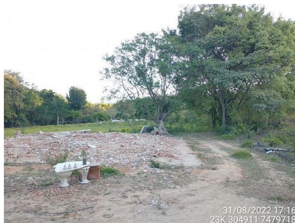
Foto 10 – Demolição de mais uma estrutura da casa 14 no laudo 15. (Data: 31/08/2022).
