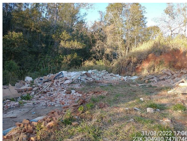
Foto 14 – Demolição da casa 41 no laudo 26. (Data: 31/08/2022).
