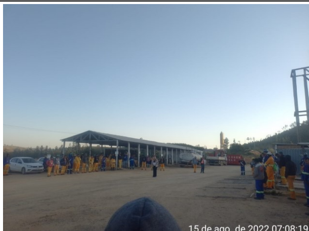
Foto 1 - Treinamento Compliance , Código de Conduta, Canteiro Industrial Barragem Pedreira. Data: (15/08/2022).
