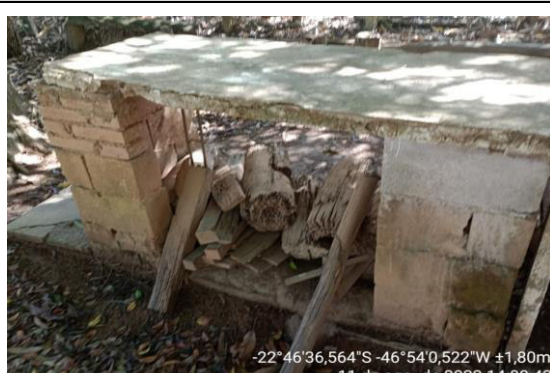
Foto 4 - Estrutura do lado de fora
