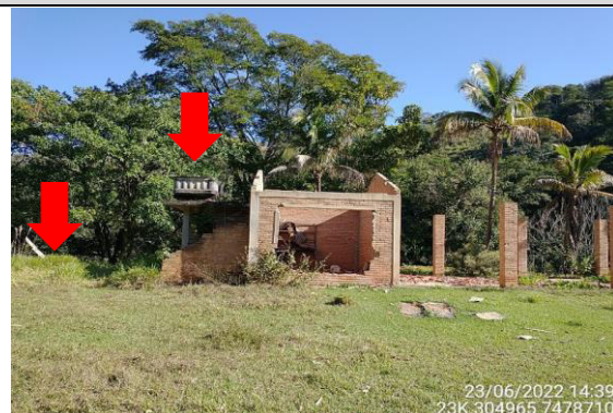
Foto 4 - Caixa d'água e caixa de concreto de esgoto indicadas pelas setas vermelhas
