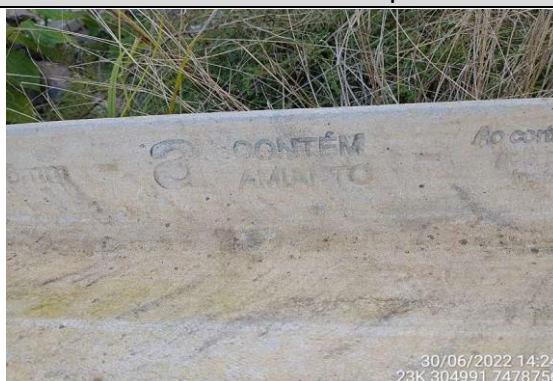
Foto 4 - Telhas e caixa d'água de amianto
