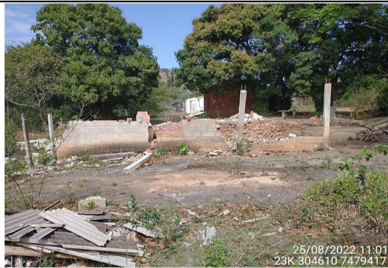
Foto 1 - Estrutura da casa 22b
