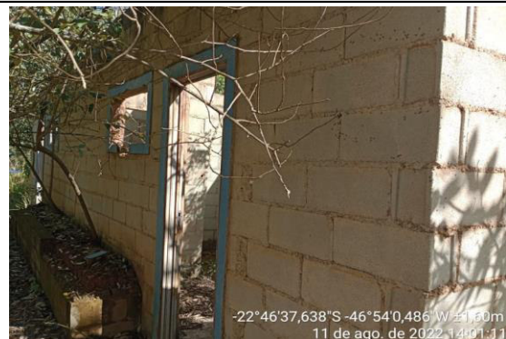
Foto 3 - Exterior da estrutura
