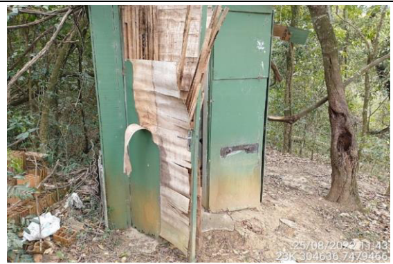
Foto 3 - Banheiro de madeira
