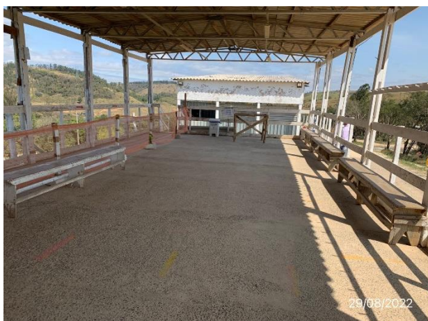
Foto 13 – Limpeza e organização na área de Vivência do Canteiro Industrial. Data: (29/08/2022).
