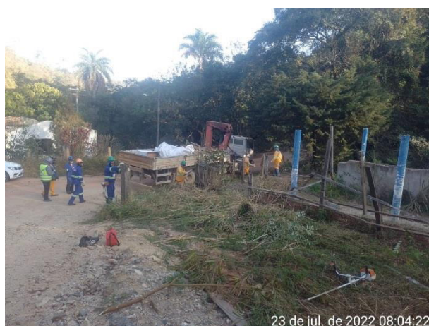
Foto 1 - Limpeza e segregação dos resíduos (Laudo 26 - Casas 42 e 41). (Data: 23/07/2022).
