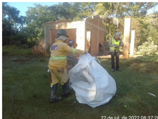
Foto 4 - Limpeza e segregação dos resíduos (Laudo 26 – Casa 43). (Data: 22/07/2022).
