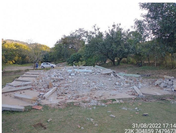
Foto 11 – Demolição da casa 15 no laudo 14. (Data: 31/08/2022).
