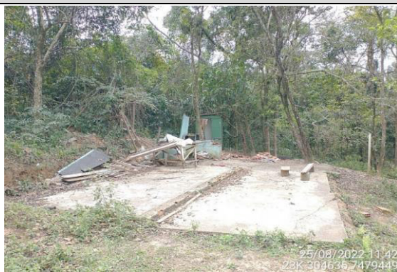
Foto 2 - Piso da casa 20
