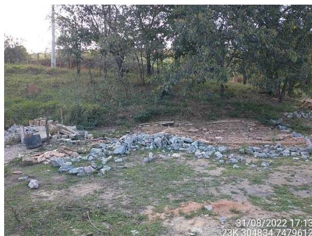
Foto 12 – Demolição da casa 16 no laudo 14. (Data: 31/08/2022).
