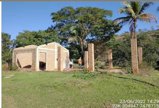
Foto 1 - Visão externa da estrutura
